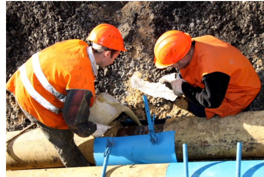
Рис. №4. Монтаж мобильной опалубки и заливка ППМ композиции.
