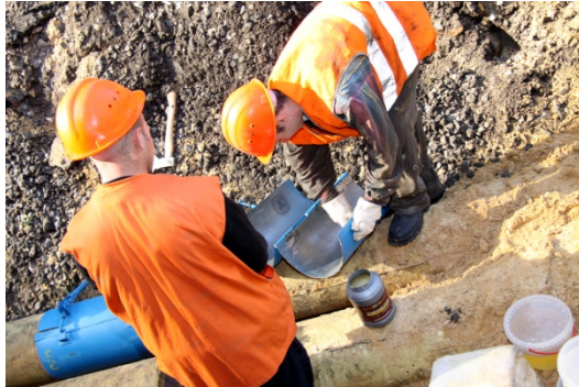
Рис. №3. Подготовка мобильной опалубки для изоляции.
