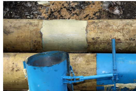
Рис. №6. Демонтаж мобильной опалубки.
