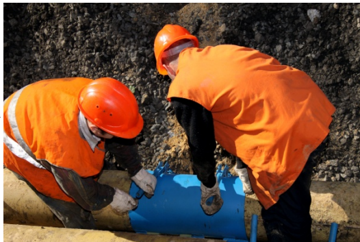
Рис. №5. Фиксация мобильной опалубки и выдержка до завершения процесса полимеризации.
