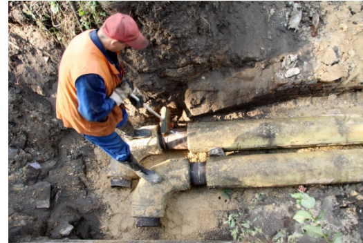
Рис. №2. Подготовка сварного стыка для изоляции.
