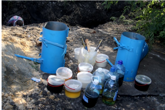
Рис. №1. Компоненты для изоляции стыка и мобильная съёмная опалубка.
