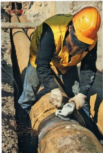
Обработка шва трубы.
